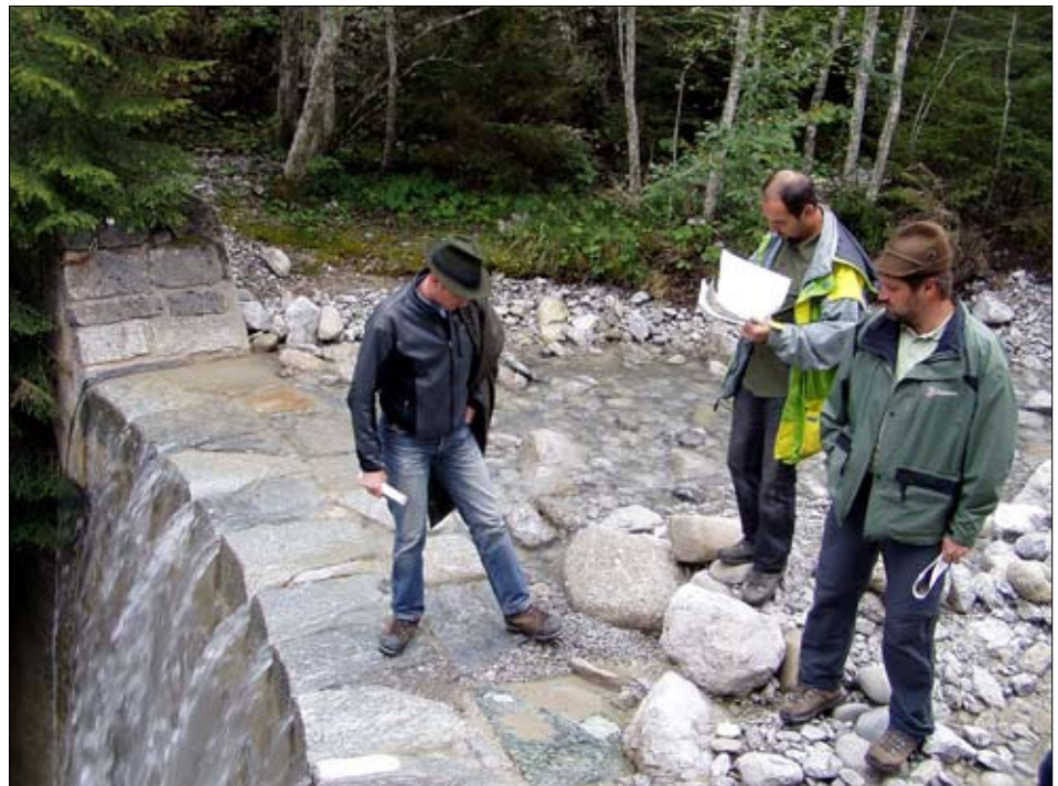
Mitarbeiter der Gebietsbauleitungen der WLV schulen die Waldaufseher bei der Wildbachbetreuung. (Foto: Gruppe Forst)
